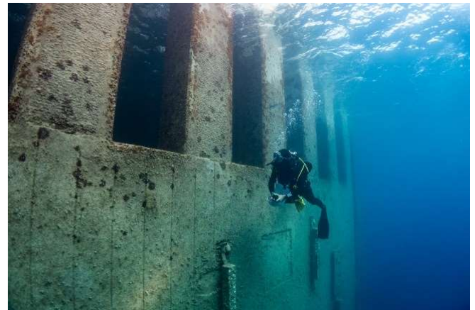
Plongeur le long de la nouvelle infrastructure maritime du quartier de l'anse du Portier (Monaco 2021)
